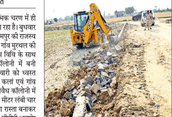
सोनीपत। जेसीबी के जरिए अवैध निर्माण हटाते हुए।
